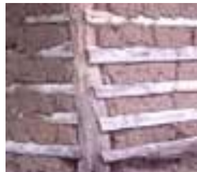
Detalle de una pared de bahareque- Página digital disponible en la web: http://www.ibague-tolima-tripod.com/.../bahareque1th.jpg
