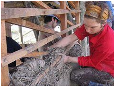
Detalle constructivo de una pared de Bahareque. Página digital disponible en la web: http://www.es.wikipedia.org/wiki/bahareque
